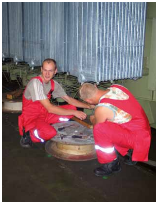
Стручна обука за монтажу Трансформатора
