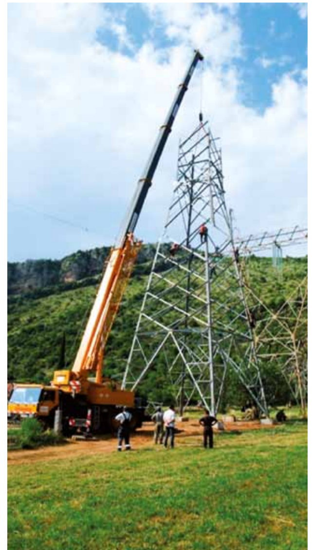
Постављање далековода у Црној Гори
